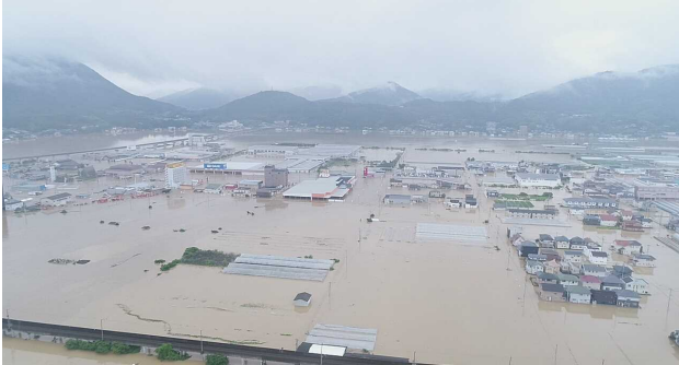
図-1 平成30年7月豪雨被災状況（東大洲地区）※大洲市提供
