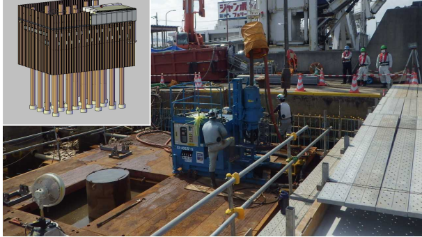
写真-1 地盤改良施工状況 (左上図：BIM/CIMモデル)
