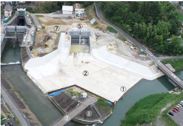
図-3 導水路施工状況 (R5.6.5撮影)
