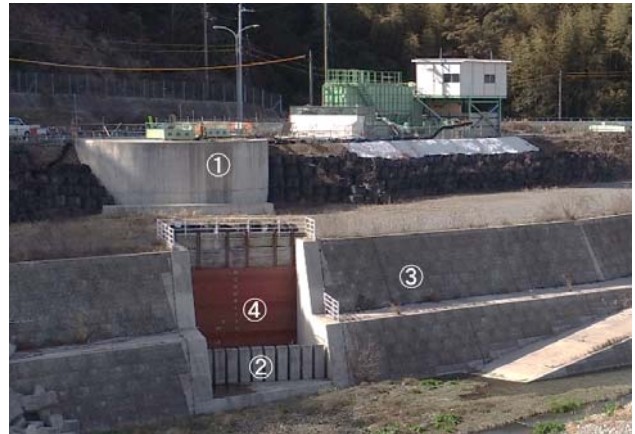
図-5 吐口部施工状況 (R5.2.14撮影)
