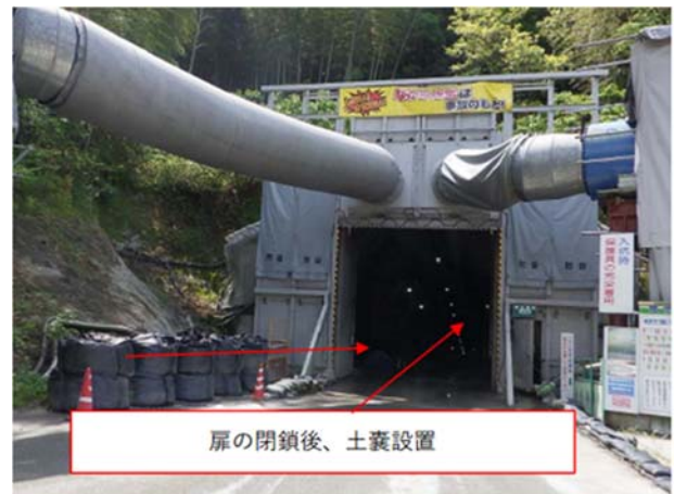
図-8 吐口側作業坑の溢水防止対策
