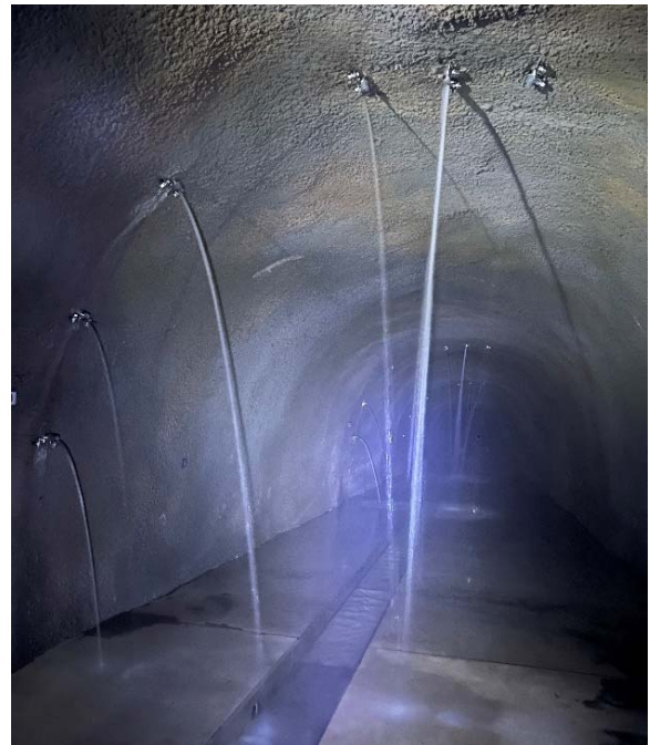
写真-3 集排水ボーリングからの排水状況
