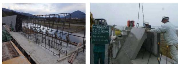
写真-6 胸壁施工状況（左：現場打ち、右：プレキャスト）
