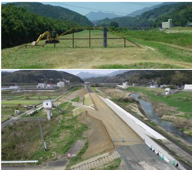
写真-3 東大洲地区の堤防（上：施工前、下：施工後）
