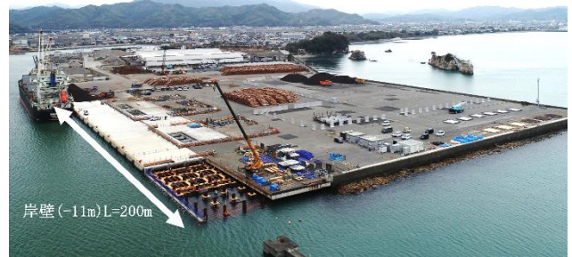
写真-2 金磯地区岸壁(-11m)全景 (R43 撮影)
