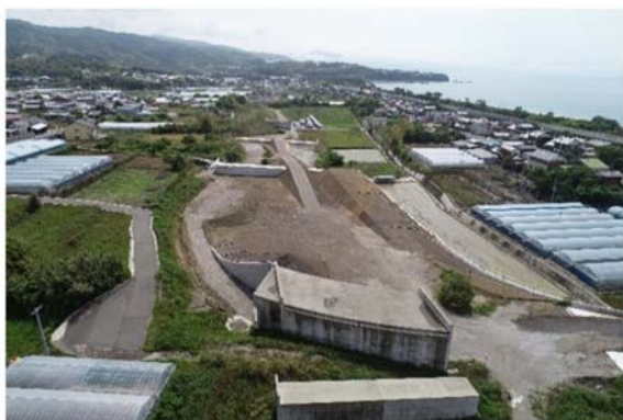
図-1 施工現場の航空写真
