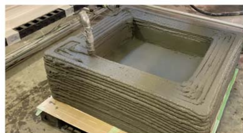
図-4 3Dプリンターによる印刷の様子
