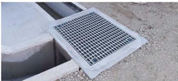
図-5 設置した集水桝の様子
