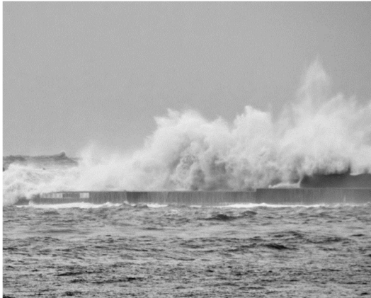
写真-1 台風時の防波堤越波状況
