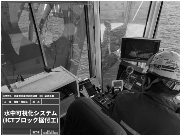
写真-4 水中可視化システムの使用状況(ブロック据付)
