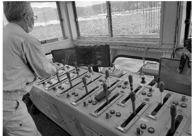
写真-2 AR カメラと自動追尾 TS を確認するオペレーター
