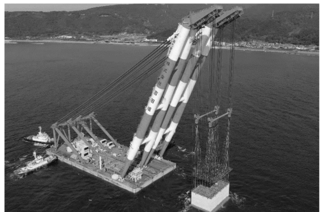
写真-6 ケーソン据付作業状況
