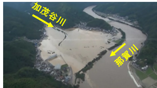
図-2 加茂地区浸水状況 (H26年8月10日)
