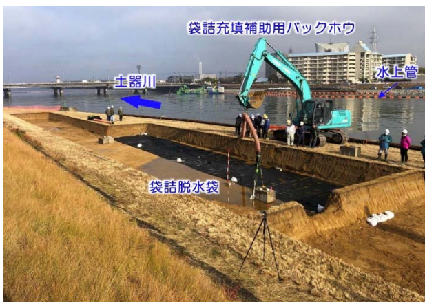
写真-3 袋体への充填状況その1
