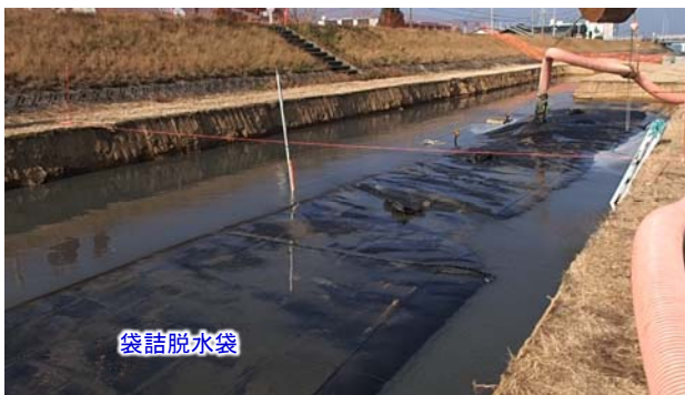
写真-4 袋体への充填状況その2
