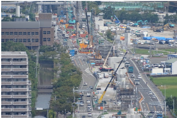
写真.1-2 橋脚工事 (H30.9) の様子
