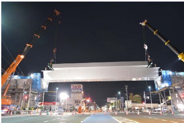
写真.1-3 交差点部での一括架設(H31.2)
