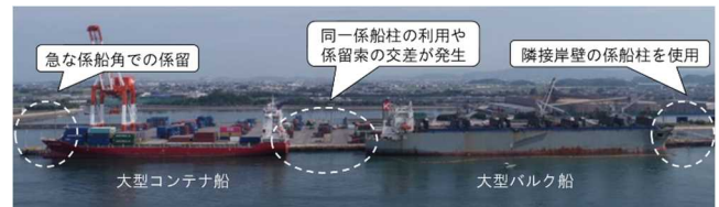
図-4 岸壁延長不足による危険な船舶係留状況
