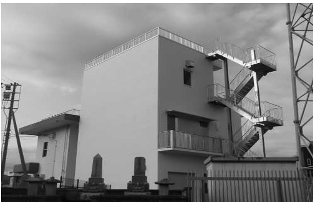
写真-2 新築電気室棟
