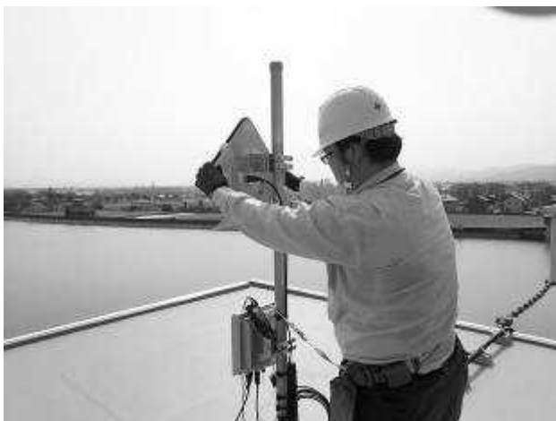
写真-6 直営による方向調整状況
