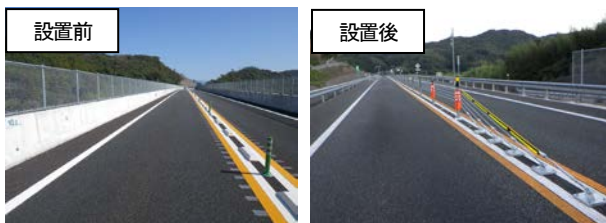
写真-1 ワイヤロープ設置前後の状況
