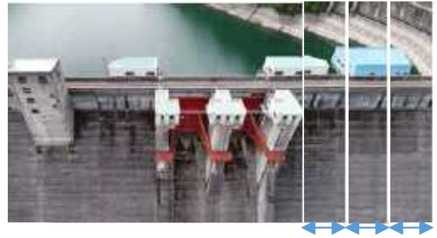
図-1 横方向の撮影進度
