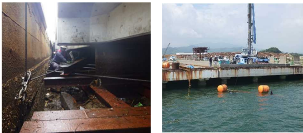
図-6 搬出作業の様子
