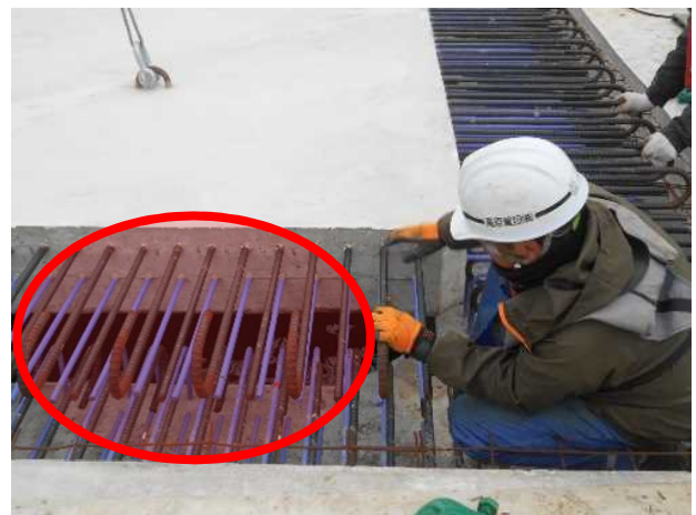
図-16 据付位置調整状況
