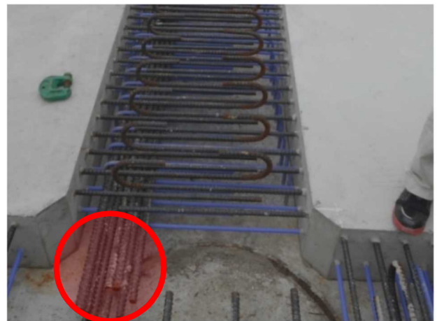
図-11 プレキャスト床版据付状況 (図-10 ④)
