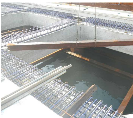
図-14 支保材撤去状況
