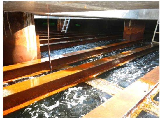
図-15 開口部を設けた橋下空間の状況
