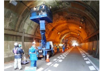
写真-1 点検の状況
