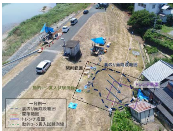
図-3 堤防裏のり面陥没・ずれ下がり状況
