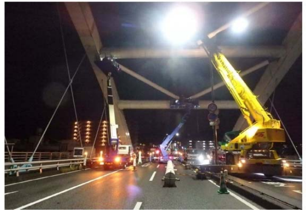
写真-2 クレーンの据付け状況
