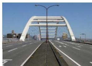
写真-1 全景写真
