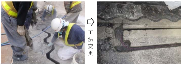
写真-4 コンクリート撤去の工法変更
