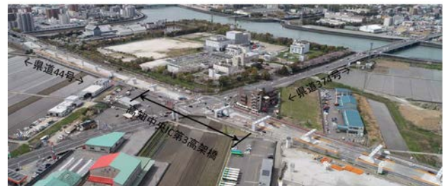
写真-5 高知中央IC第3高架橋周辺の上空写真
