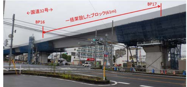
写真-4 桁架設完了後の写真
