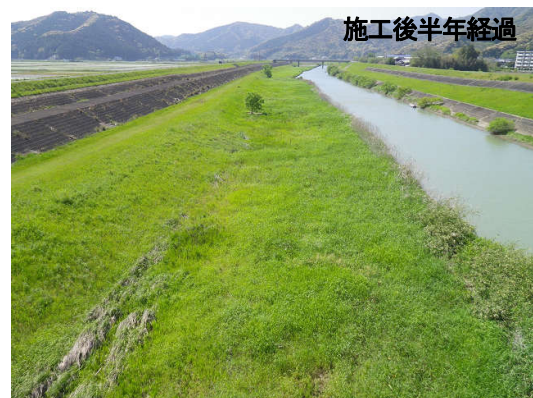
写真-4 試験施工(BD踏み倒し)の経過
