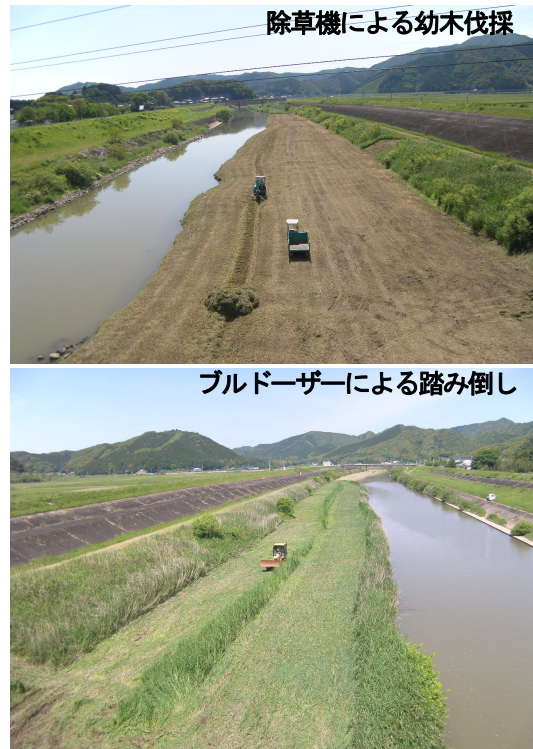
写真-3 樹木再繁茂抑制対策工の実施状況
