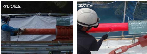
写真-5 施工状況
