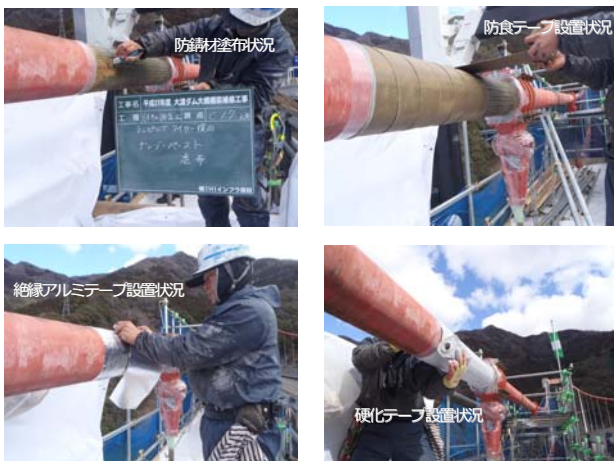
写真-9 施工状況
