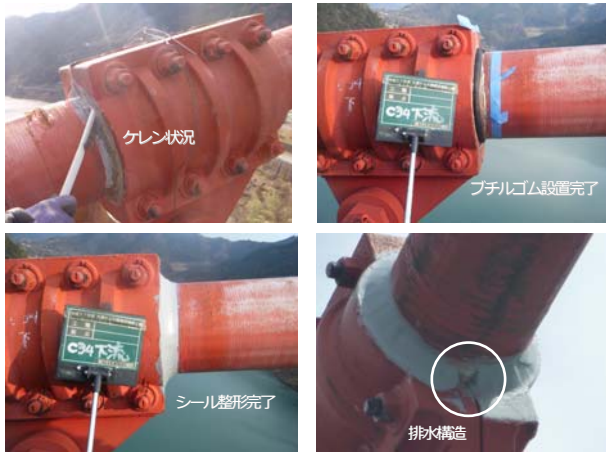
写真-8 施工状況
