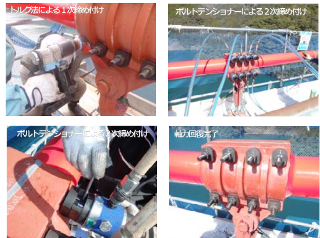
写真-7 施工状況
