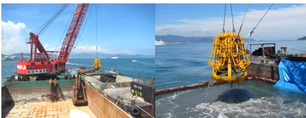
写真-2 海上での浚渫状況
