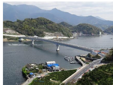
写真-7 九島大橋全景
