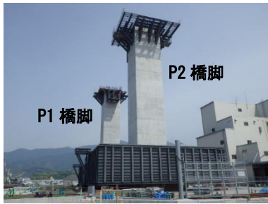
写真-3 完成したプレキャストRC橋脚
