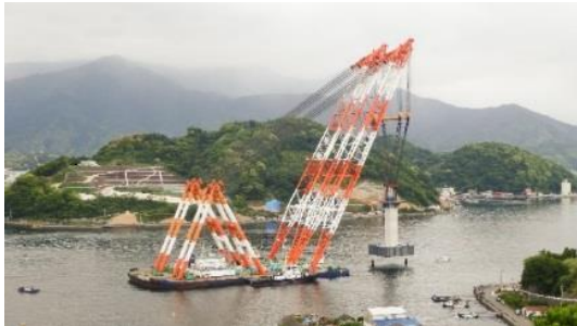
写真-4 起重機船による据付状況（P2橋脚）
