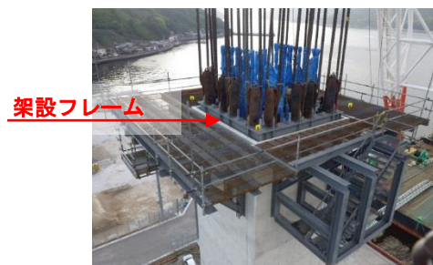
写真-1 架設用フレーム(玉掛け後)
