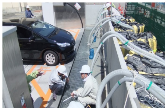
図-17 車両を載せての起立確認試験
