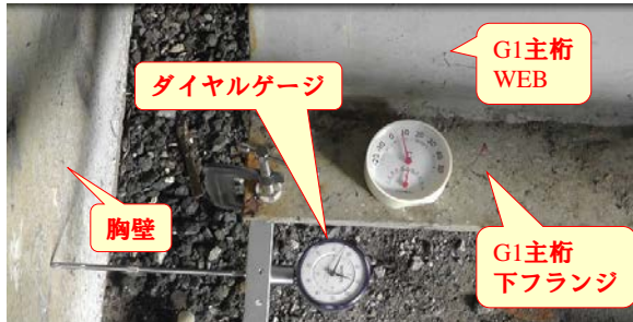
写真-2 桁の挙動調査状況
