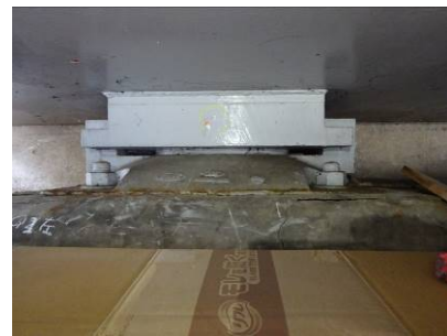
写真-3 支承の状況写真
