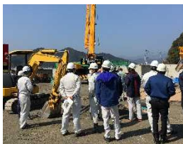
図-13 ブロック製作工事現場
