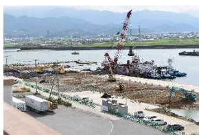
図-5 岸壁工事現場の様子
