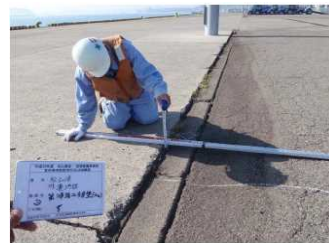
図-9 エプロン上の段差 図-10 エプロン上ひび割れ
