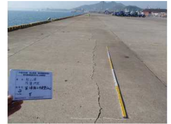
図-9 エプロン上の段差 図-10 エプロン上ひび割れ
