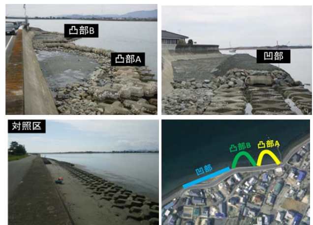
図-3 調査地点写真
