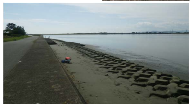
図-1 上：既設護岸 下：現地写真（耐震対策後）
