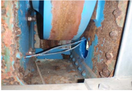
写真-2 ゲート可動部の状況
