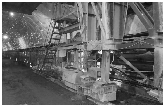
図-11 覆工部連続ベルトコンベア稼働状況
