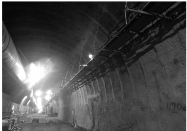
図-10 掘削部連続ベルトコンベア稼働状況
