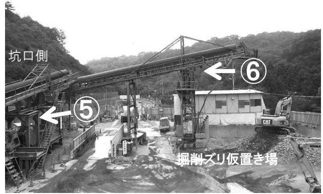
図-5 坑外設備配置
