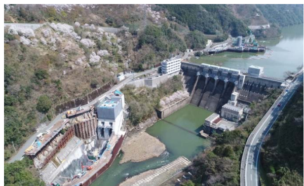
写真-4 鹿野川ダム改造事業(H30.3.27)
