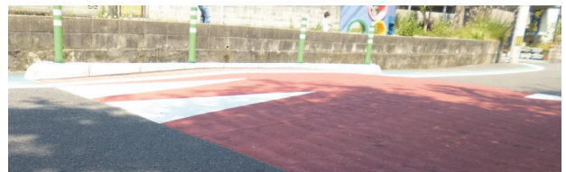
写真-1 ハンブの設置状況
