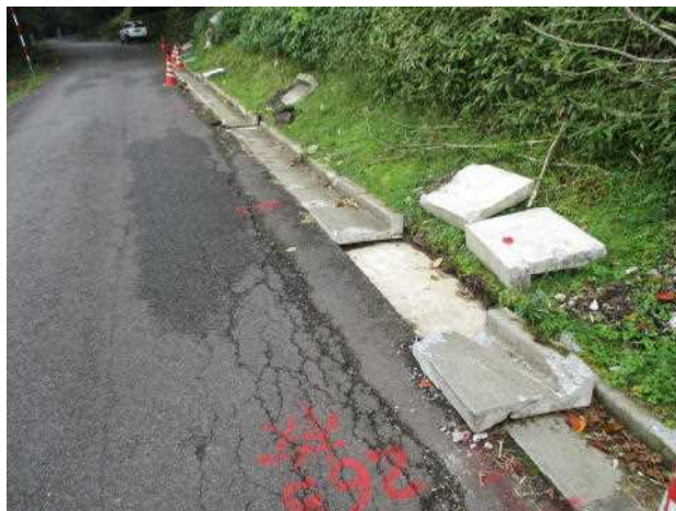
写真-3 側溝下の均しコンクリートの状態確認
