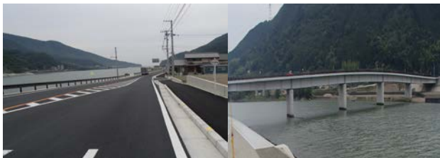
写真-5 大洲長浜線整備状況
