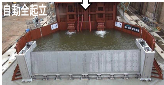
図－9 工場試験状況
