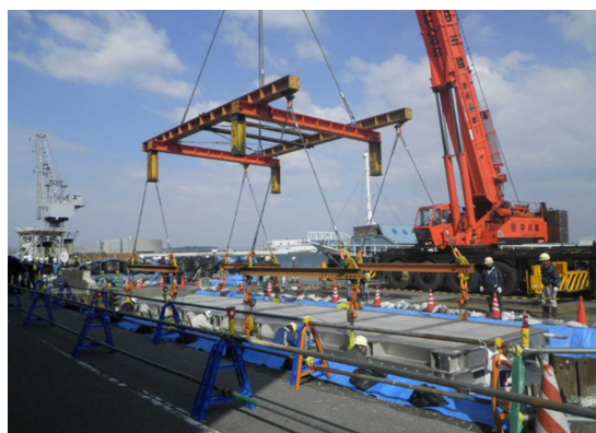
図-12 ゲート据付状況
