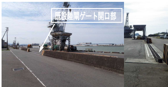
図-5 既設陸閘(横引きゲート)
