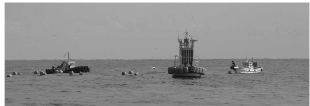
写真-6 設置完了
