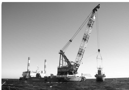
写真-4 GPS波浪計ブイ着水状況
