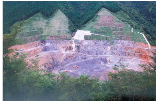
図-5 掘削中の原石山事例
