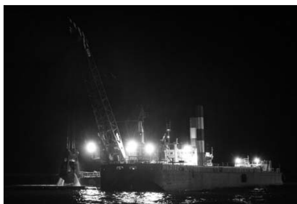
図-5 夜間浚渫状況
