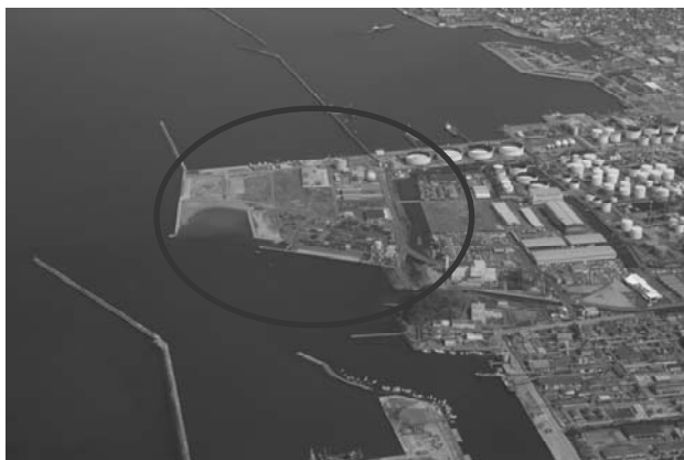
図-1 松山港外港地区
