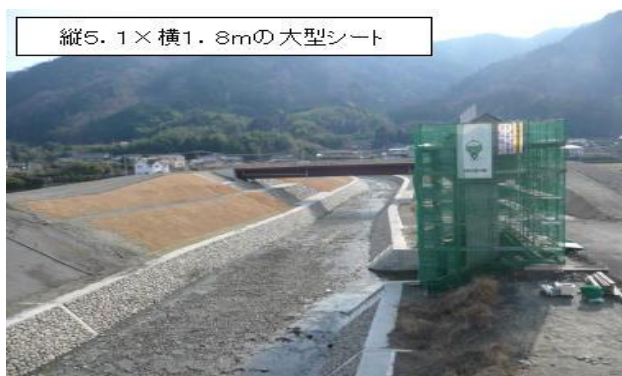
写真－7 国道192号から見た工事現場
