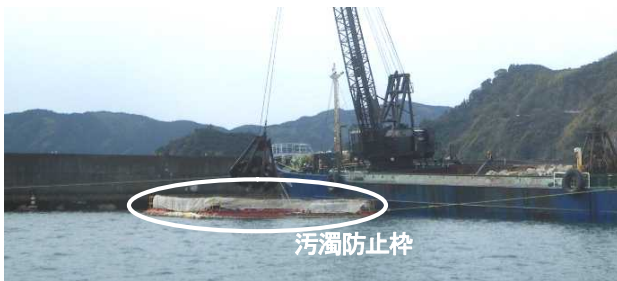
写真-6 環境に配慮した腹付工の施工(石材投入)
