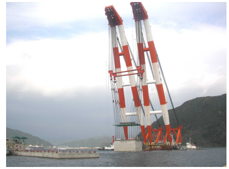
写真-4 ケーソンの据付状況
