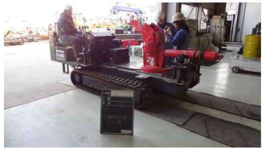
写真-2 小型クローラクレーンの分解状況
