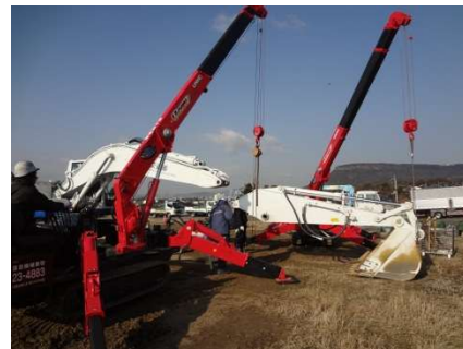
写真-6 分解組立型バックホウの組立状況(2)
