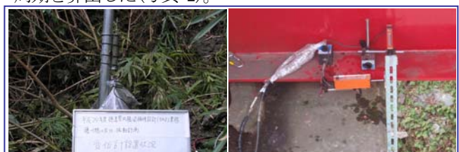
【写真-2. 変位計測状況写真】
