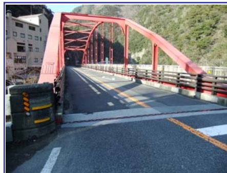
写真-1. 藤川橋現況写真
