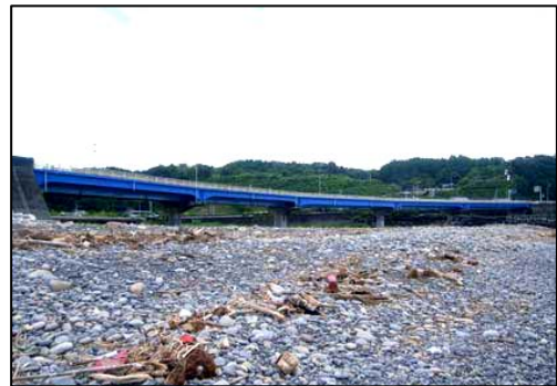
写真-9 安田川大橋側道橋（下り）
