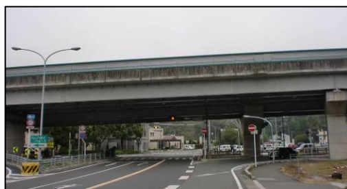
写真-1 北只跨道橋（下り）
