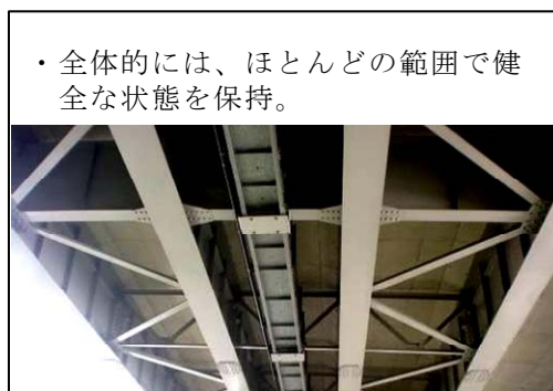
写真-2 主桁等の塗膜健全度
