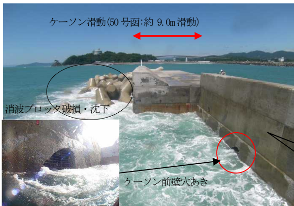
写真-2 50号函被災状況 (2011年7月21日撮影)
