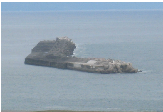
写真-5 防波堤(南)現況全景(2013年6月11日撮影)
