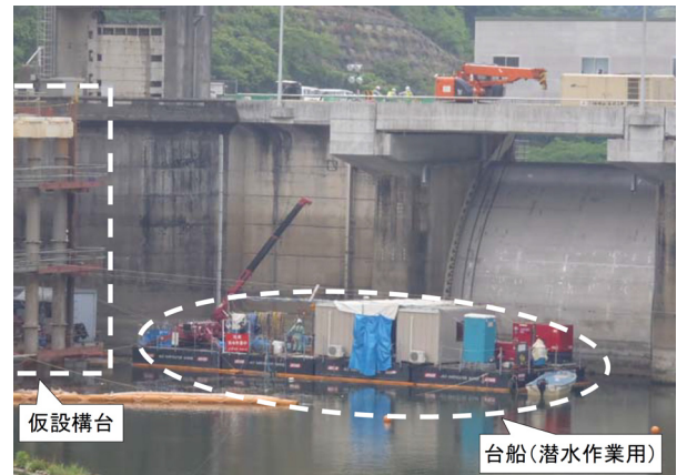
写真-1 工事状況全景 (ダム上流側より堤体左岸側を臨む)
