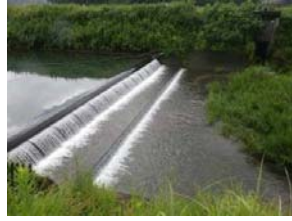
写真-2 ラバー堰
