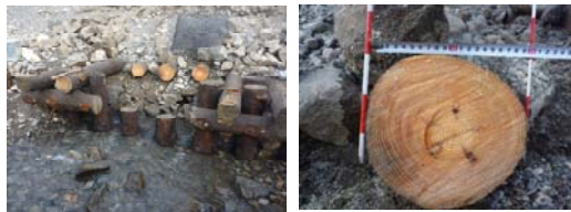
図-4 既設木工柱確認状況
