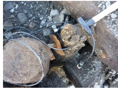
図-7 木工柱天端部の測定状況
