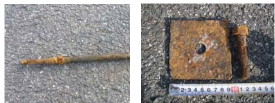
図-8 継ぎ材の状況
