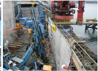
写真-5 施工状況 (全景)
