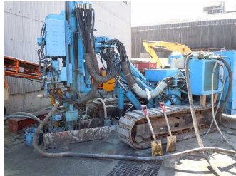
写真-4 施工状況 (近景)
