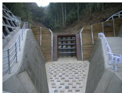
図-2 障子ヶ谷堰堤
