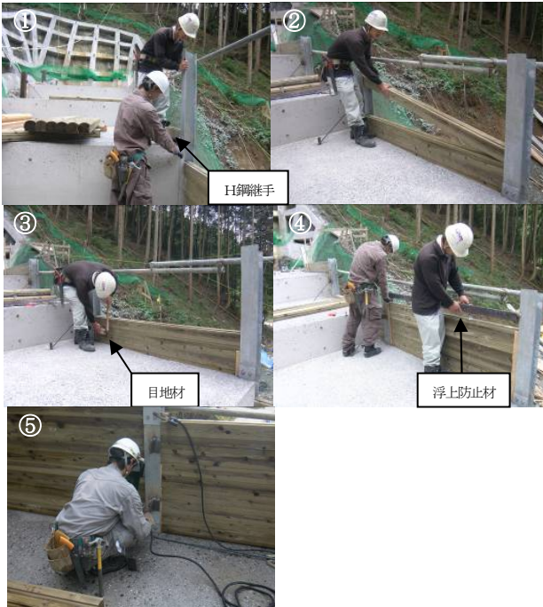
図-7 改良工法施工状況写真
