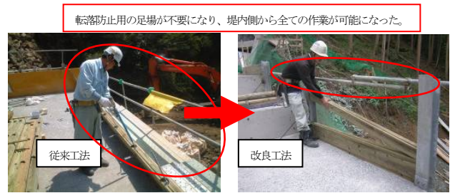
図-10 従来工法との比較写真 (間伐材設置施工時)
