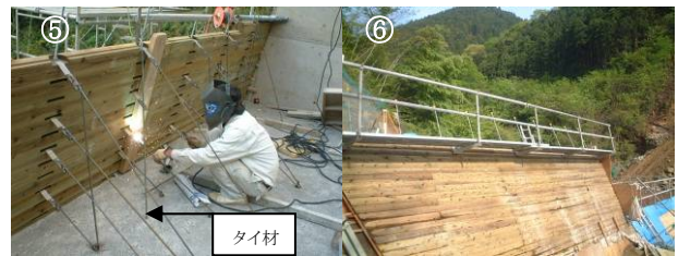
図-5 従来工法施工状況写真
