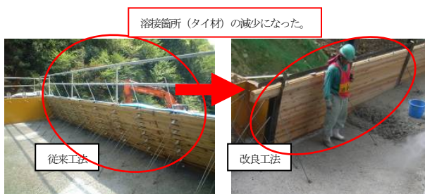
図-9 従来工法との比較写真 (タイ材比較)
